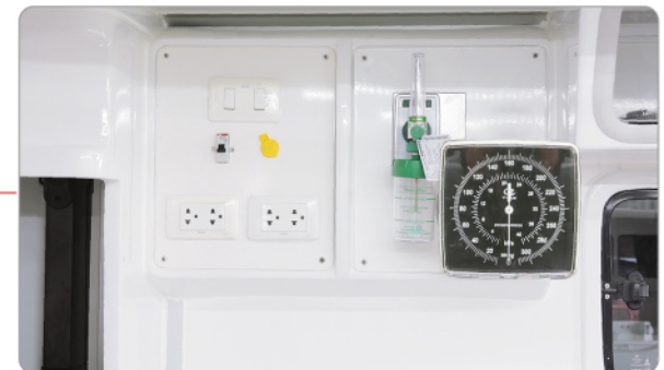
แผงคอนโทรลระบบไฟห้องโดยสาร ผลิตจากไฟเบอร์กลาสติดตั้งระบบออกซิเจน และเครื่องวัดความดันโลหิต
